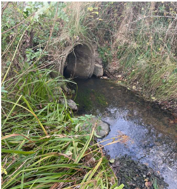
Figur 36 Trumma under vägbank i norra delen av planområdet, se punkt 2 i Figur 34. Fotad från söder. Vattnet i diket som är kulverterad leds norrut.
