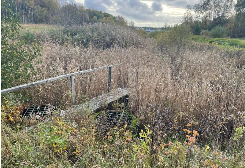
Figur 37 Dagvattendamm med dämpningsbrunnar i centrala delen av planområdet, se punkt 3 i Figur 34. Fotad från norr.
